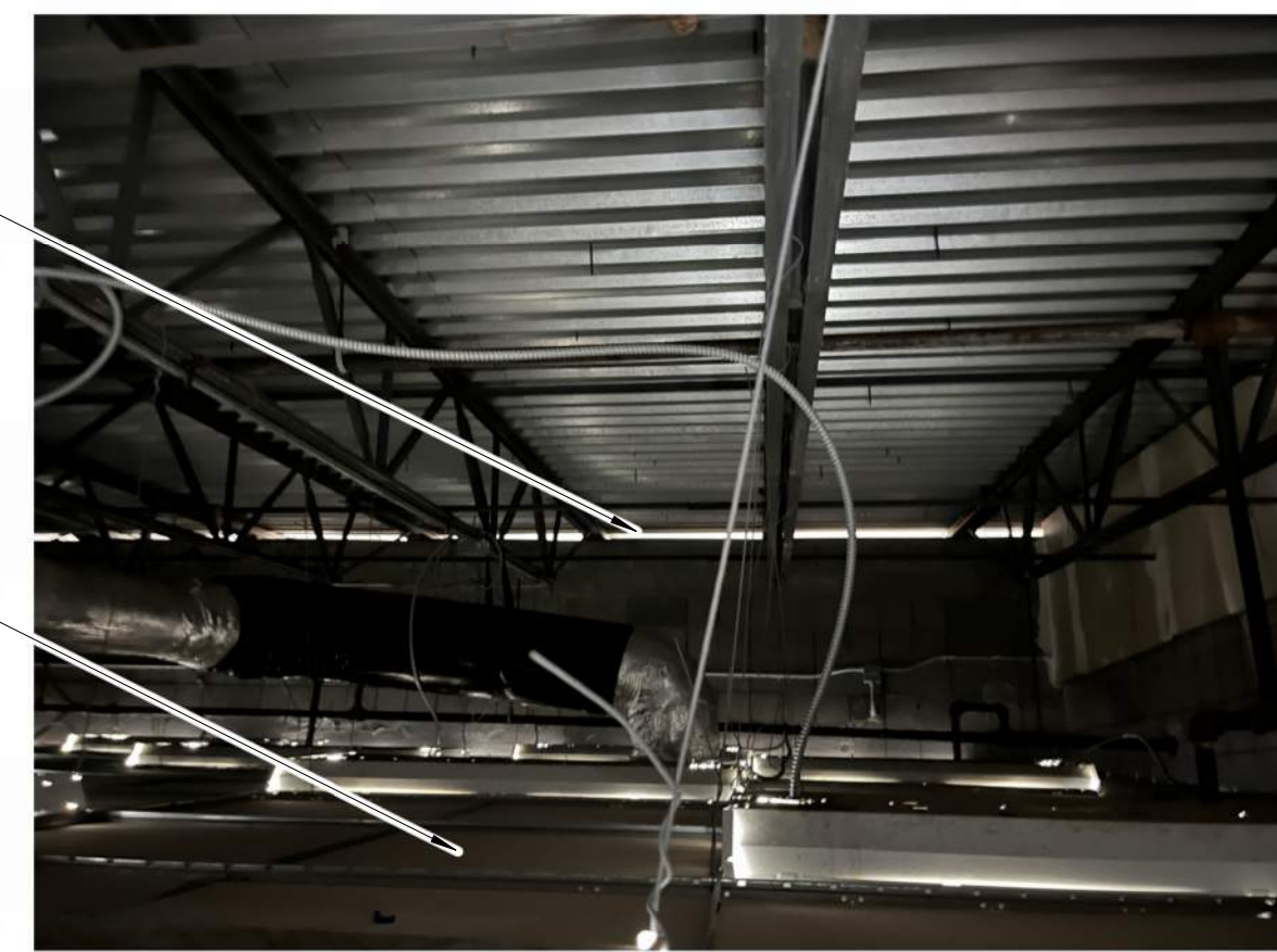
4 PHOTO - ABOVE EXISTING CEILING (INTERIOR) Scale: N.T.S.
