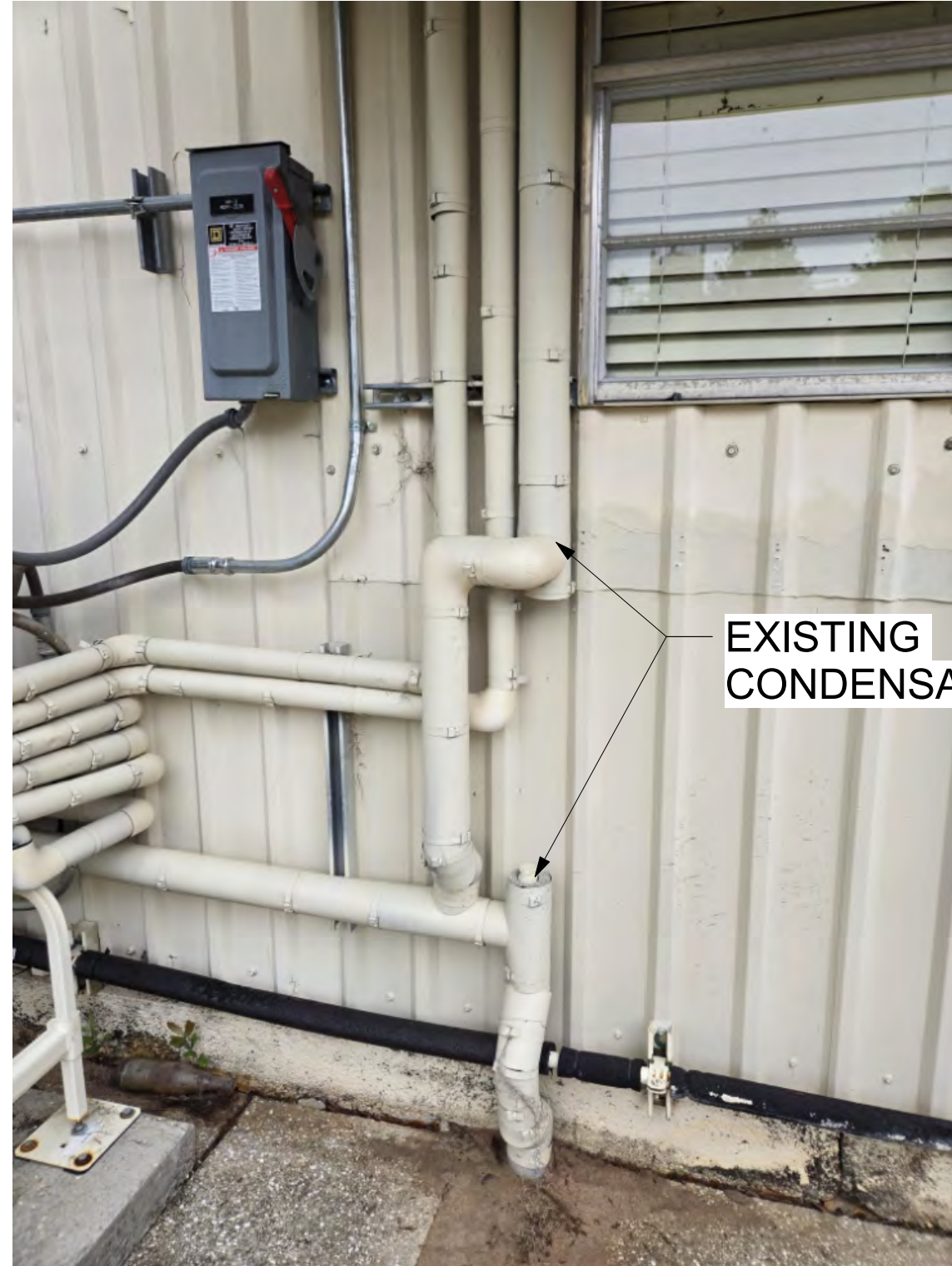
2 CONDENSATE RISER M1.1 No Scale
